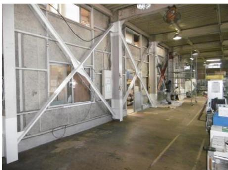
図2 ブレースによる耐震補強事例
