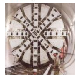
ユーロトンネル仏側 TBM
