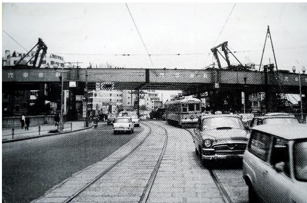
首都高速日本橋の建設工事中の状況
