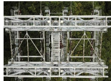
図5 UAVによる架線点検
