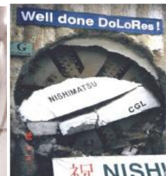
PFI DLR ルーシャム延長線工事
